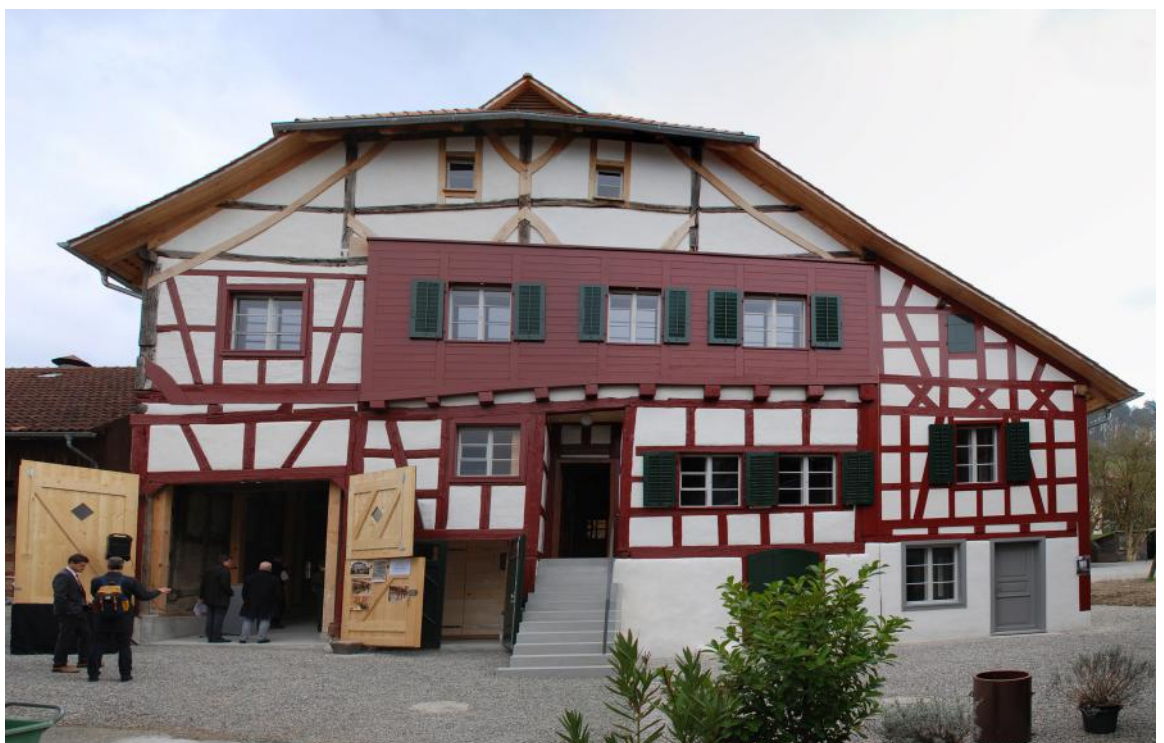
Abbildung 8: Das Girsbergerhaus in Unterstammheim aus dem Jahre 1422 nach Gesamtsanierung 2014.
